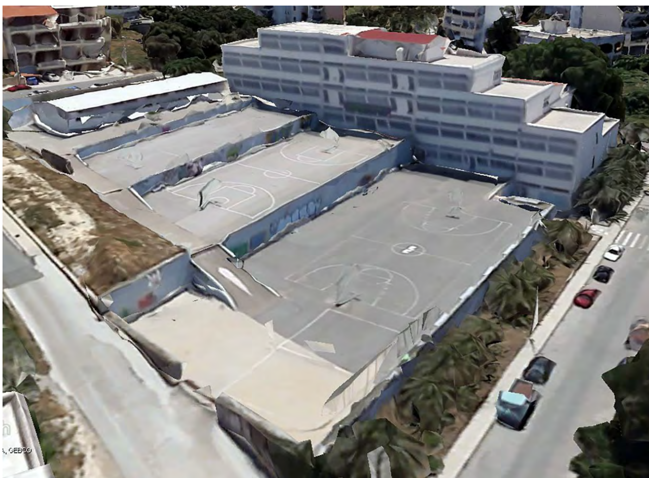
Εικόνα 1γ: Τρισδιάσταση απεικόνιση του κτηρίου του 2 ου Γυμνασίου – Λυκείου Ρεθύμνου από βορειοανατολικά.
