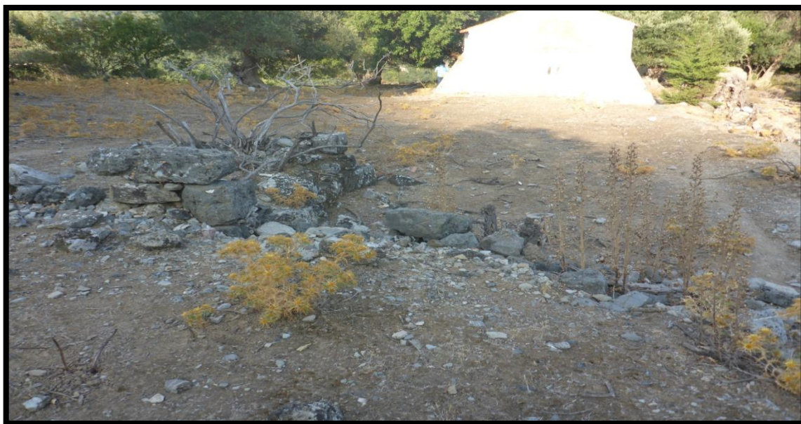
Θέση που θα χτιστεί πέτρινο τοιχίο με σκαλοπάτια για την είσοδο στην εκκλησία Άγιο Νικόλαο
