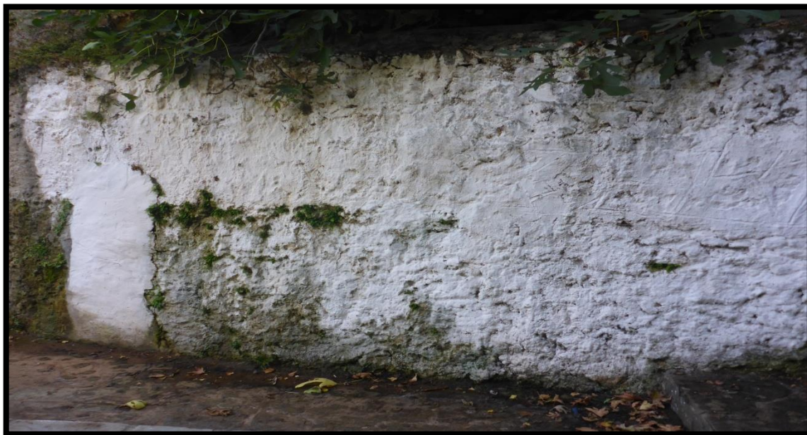
Πέτρινος τοίχος στο προαύλιο της Αγίας Δύναμης το οποίο θα καθαριστεί με αμμοβολή
