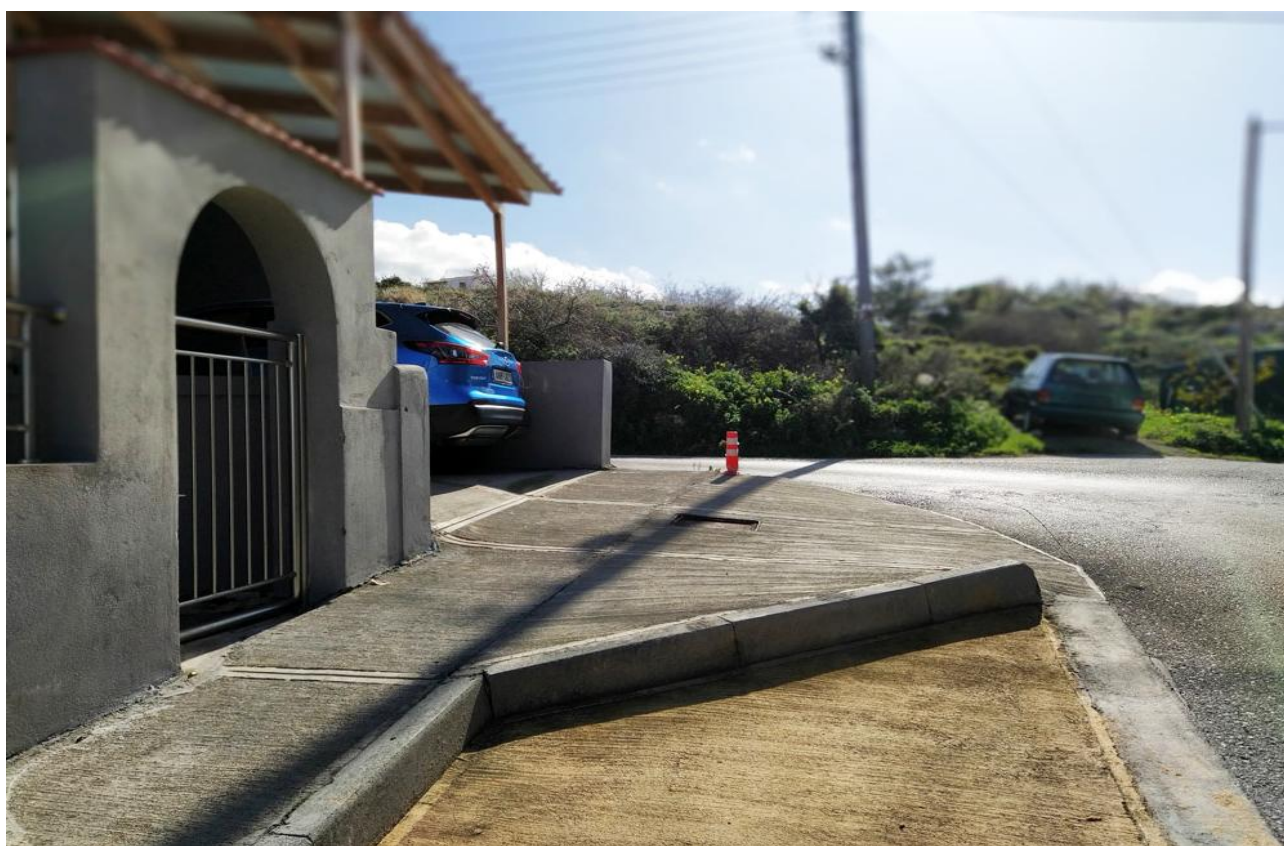
ΒΔ άνω άκρο τετραγώνου με πρόσφατη ανάπλαση με βιομηχανικά δάπεδα
