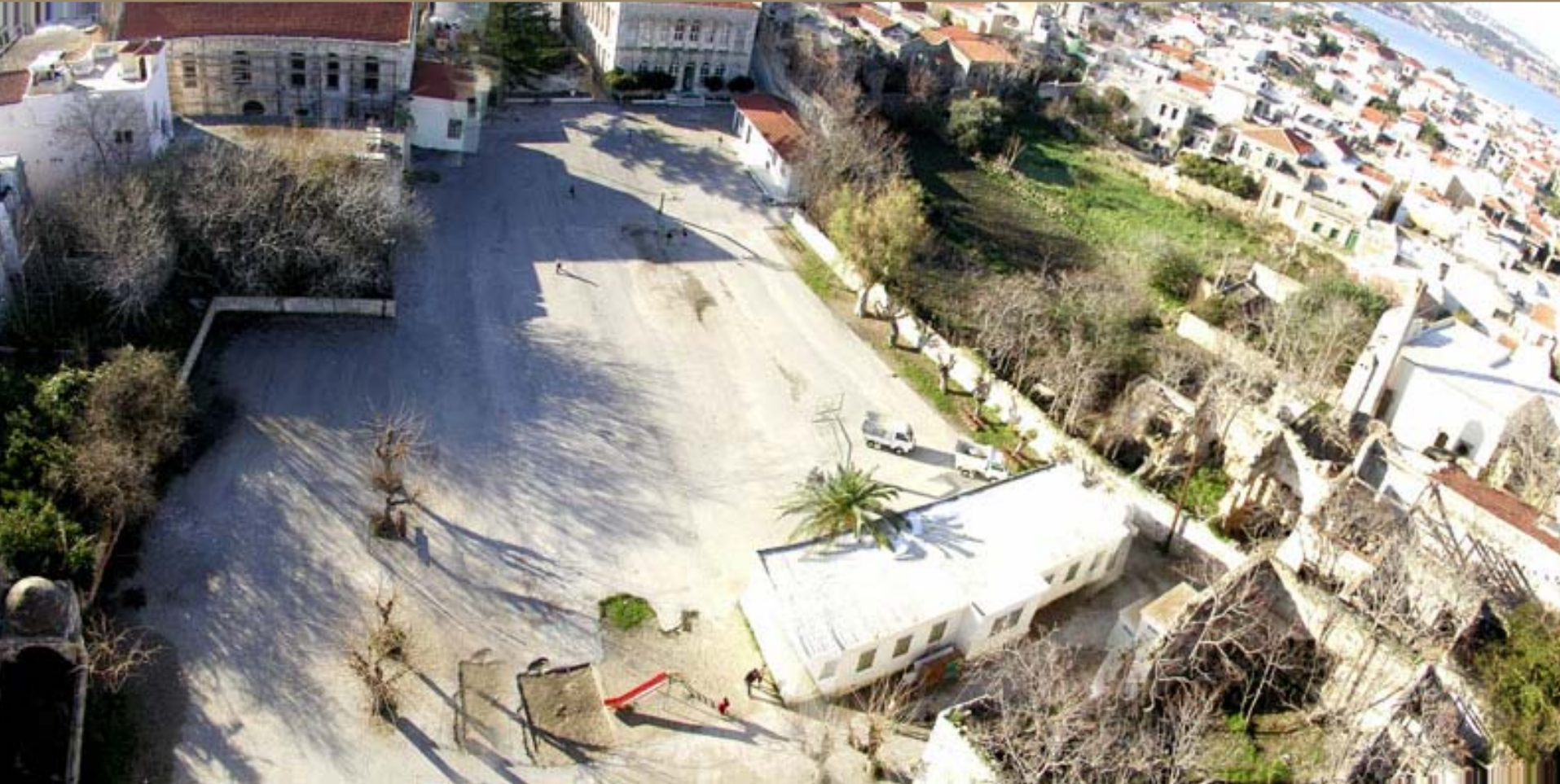
ΓΕΝΙΚΗ ΑΠΟΨΗ ΠΛΑΤΕΙΑΣ #ΑΡΧΙΚΗ ΚΑΤΑΣΤΑΣΗΣ
